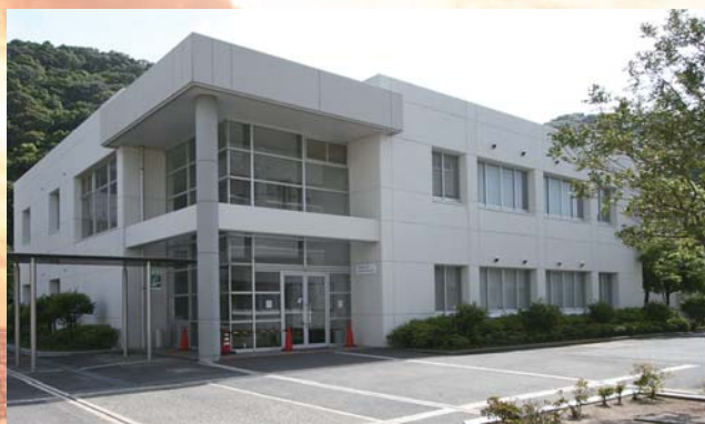
● マルチメディアネットワークセンター 平成6年度建築 RC2階建 728㎡
