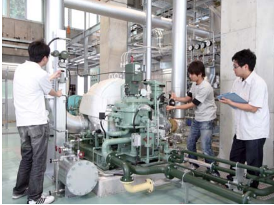
船用機械総合実験棟での実験
