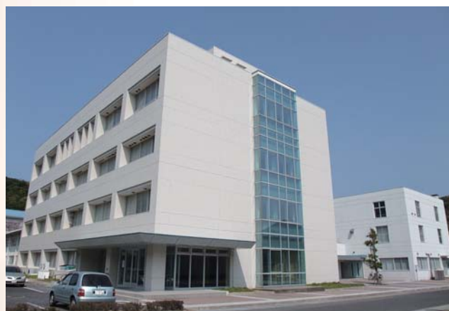
● 共同研究棟 平成11年度建築 RC2階建・4階建 1,110㎡
