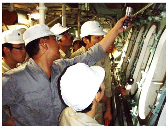
写真4 主機関のクランク点検
