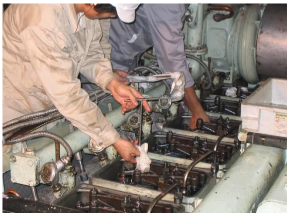
写真2 発電機の燃料噴射弁交換
