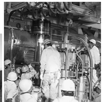
主機ピストン開放作業
