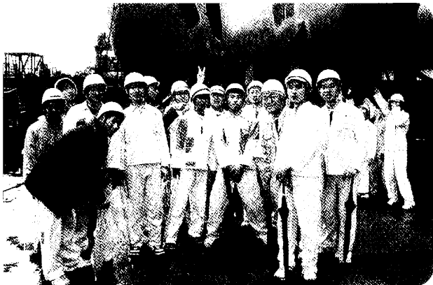
建造中の新耕洋丸を見学しています
