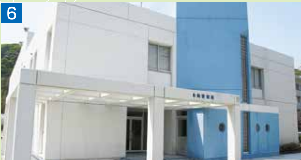
▲ 舟艇管理棟 平成8年度建築 RC2階建 1,217.58㎡
