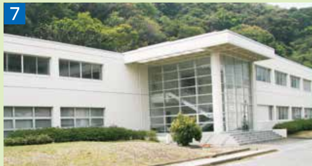
▲ 内燃・制御実験棟 昭和63年度建築 RC2階建 1,344.49㎡
