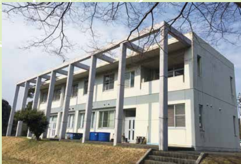
宿舎兼研究棟
