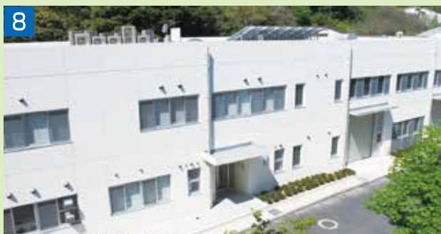
▲ 舶用機械総合実験棟 平成21年度建築 RC2階建 1,003.24㎡
